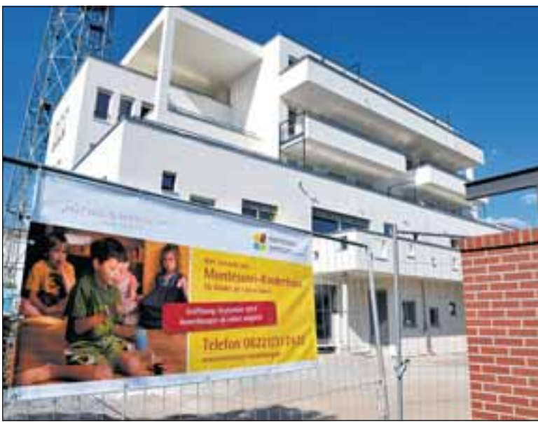
Im Rohrbacher Quartier am Turm neben dem Paulus-Heim entsteht ein Montessori-Kinderhaus. Foto: Kresin
